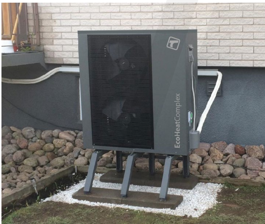
Rys. 15.3. Widok prawidłowo zamontowanego modułu zewnętrznego pompy ciepła EcoHeat Complex.
