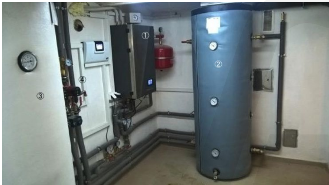
Rys. 15.5. Widok prawidłowo wykonanego węzła cieplnego z pompą ciepła EcoHeat Complex, gdzie: 1 – moduł wewnętrzny, 2 – bufor c.o., 3 – podgrzewacz c.w.u., 4 – pompa obiegowa instalacji grzewczej.
