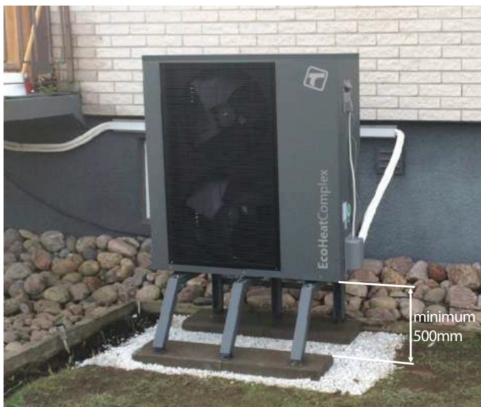
Rys. 15. Wygląd ogólny i sposób zamontowania jednostki zewnętrznej na specjalnym stelażu.
